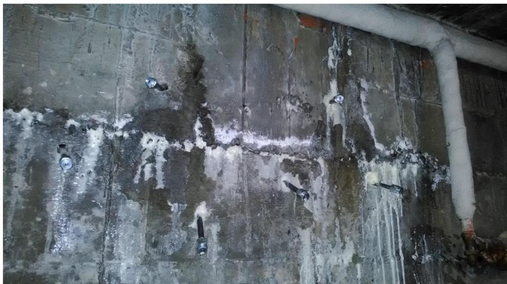
8) Interventi tra pavimento, muratura controterra e fondazione in calcestruzzo all'interno di un box presso il Condominio di via Morona 12 Trezzano Sul Naviglio.
